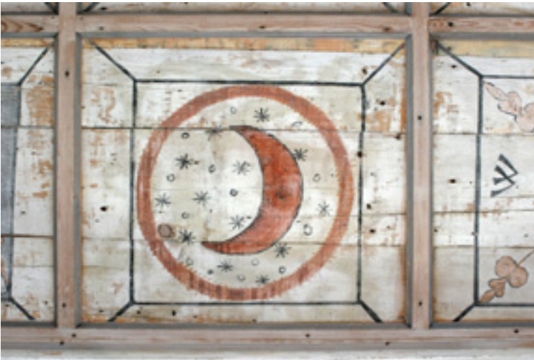
Teilstück der Kasettendecke
